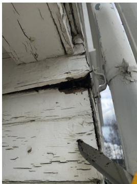
Råteskader i kledning og bindingsverk
