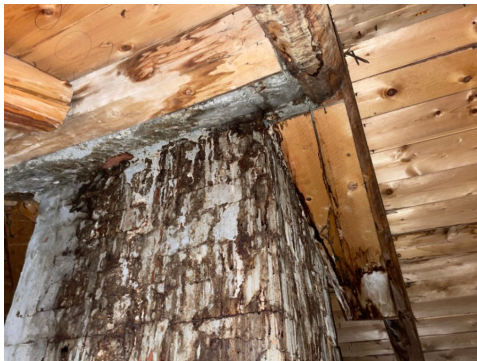
Sprekker i pipe. Synlige fuktmerker og sotvann på overflater
