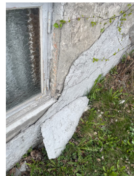
Sprekk i betong og skader i puss
