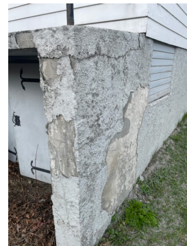
Sprekk i betong og skader i puss
