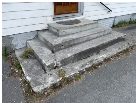
Løst terskel beslag/bord.
