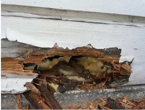
Råteskader i kledning og bindingsverk
