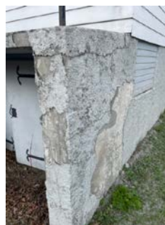
Sprekk i betong og skader i puss
