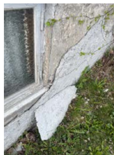
Sprekk i betong og skader i puss
