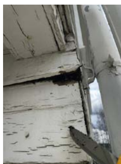
Råteskader i kledning og bindingsverk
