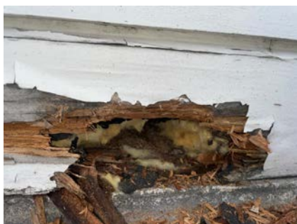
Råteskader i kledning og bindingsverk
