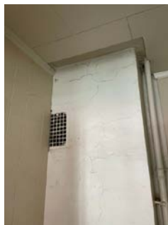
Sprekker i pipe. Synlige fuktmerker og sotvann på overflater
