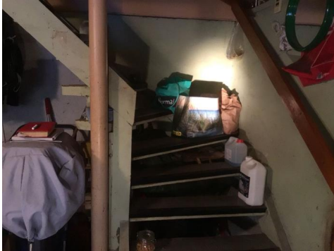
Mangler rekkverk
