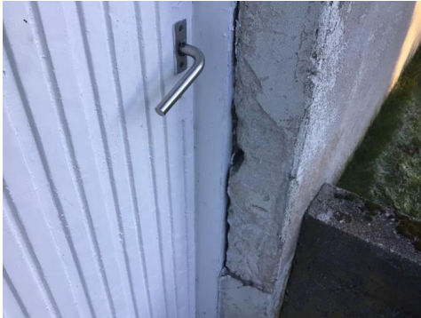
Utettheter langs kjellerdør
