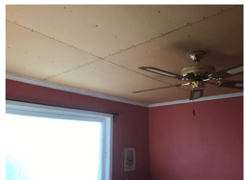
Ubehandlete plater i stue tak
