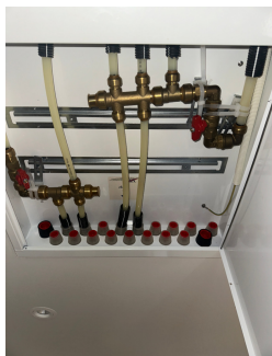
Samleskap for vannrør på bad plan 2
