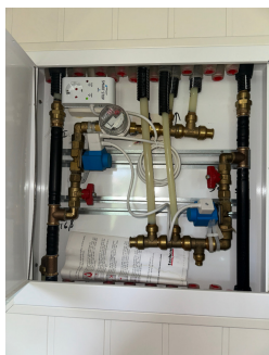
Samleskap for vannrør på bad plan 1
