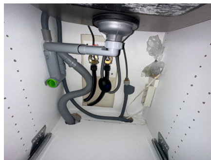
Røropplegg i kjøkkenbenk med Waterguard
