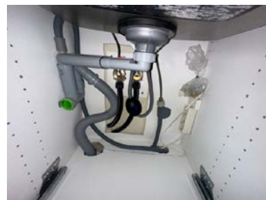
Rørapplegg i kjøkkenbenk med Waterguard
