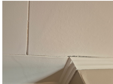
Fuktskadet takessplate.
