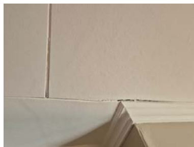
Fuktskadet takessplate.
