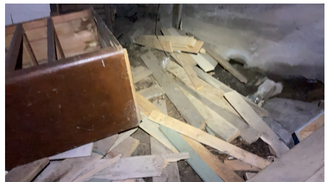
Materialer bør fjernes og dampspærre bør etableres
