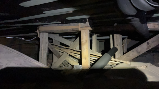
Enkel oppstøtning, langt spenn der tiltak bør foretas
