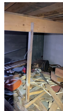
Materialer bør fjernes og dampspærre bør etableres
