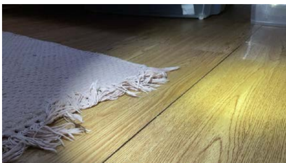
Glipper i skjøter på laminat
