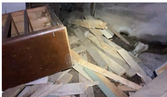
Materialer bør fjernes og dampsperre bør etableres
