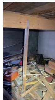
Materialer bør fjernes og dampsperre bør etableres
