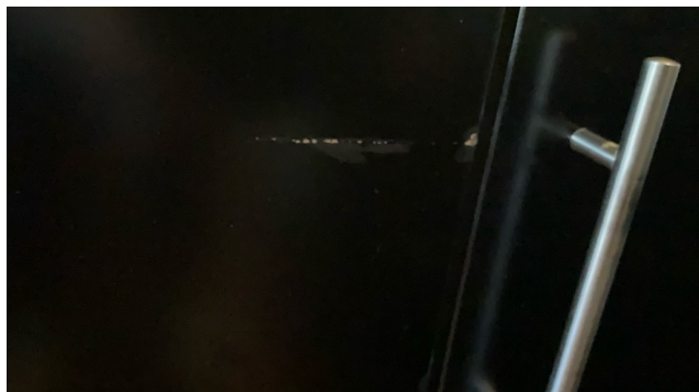
Skader i kjøkkenfront.
