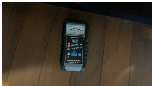
Ingen indikasjoner på fukt rundt utsatte hvitevarer.
