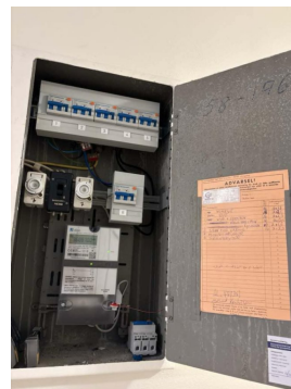
Sikringsskap med kursfortegnelse i samsvar med antall sikringer.
