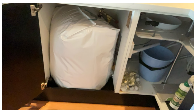
Bereider under kjøkkenbenk.
