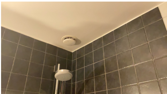
Naturlig ventilering på våtrom.
