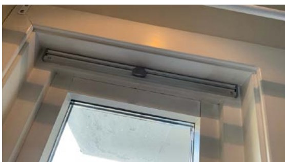
Ventiler i vindu.
