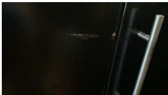
Skader i kjøkkenfront.
