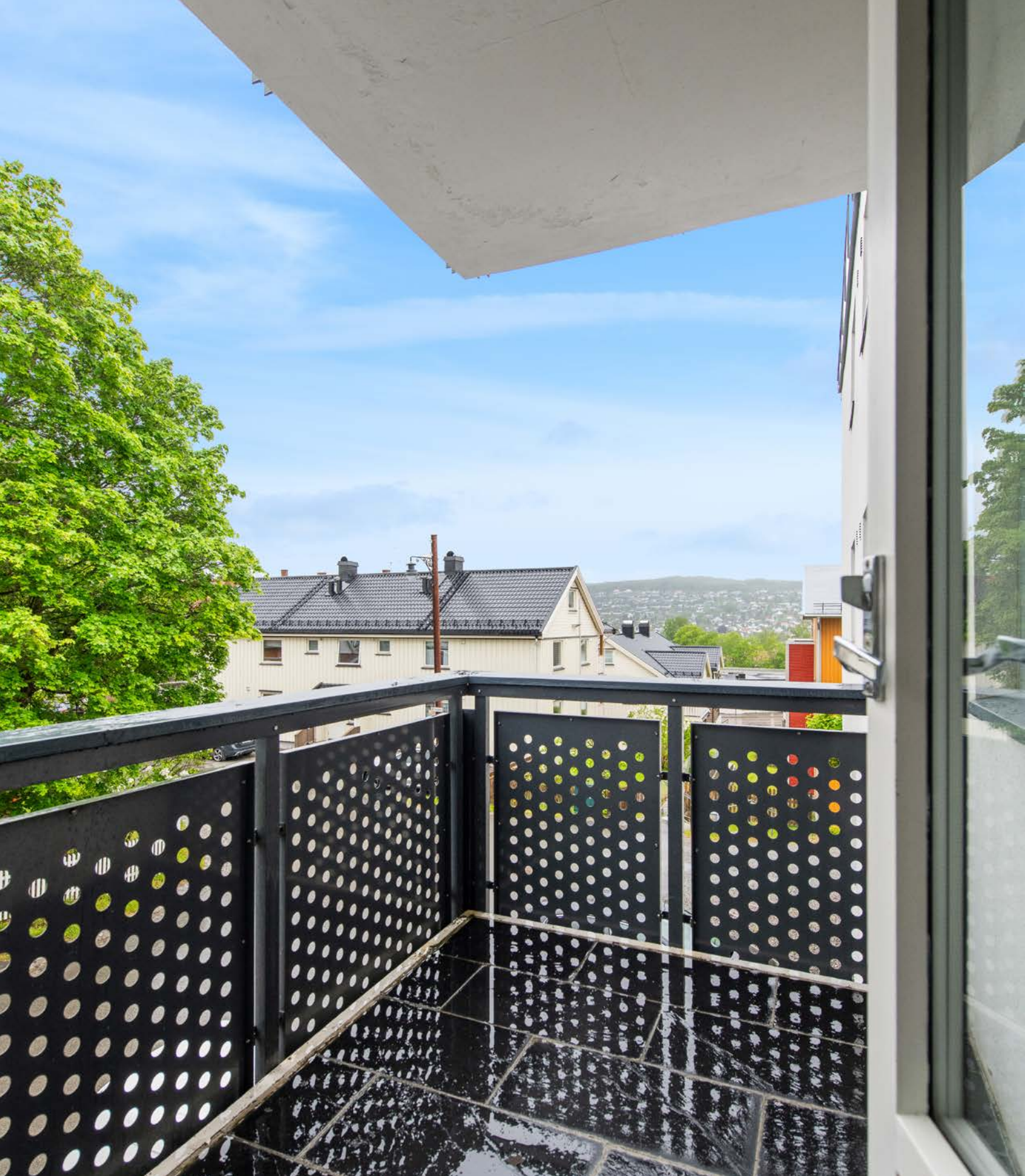
Balkong har fliser på gulv og rekkverk har aluminiumsprofiler.
