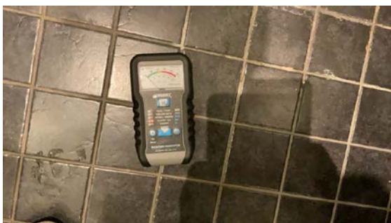
Ingen indikasjoner på fukt på gulv.
