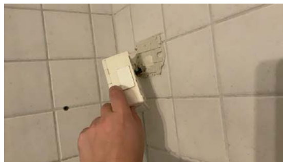
Stikk på våtrom ikke tilstrekkelig festet.
