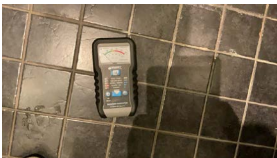
Ingen indikasjoner på fukt på gulv.
