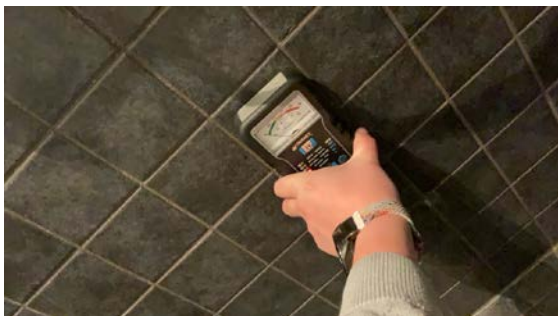
Ingen indikasjoner på fukt på vegg i våtsone.
