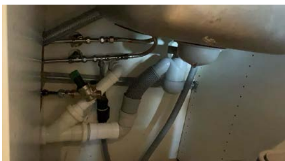
Avløpsrør av plast.
