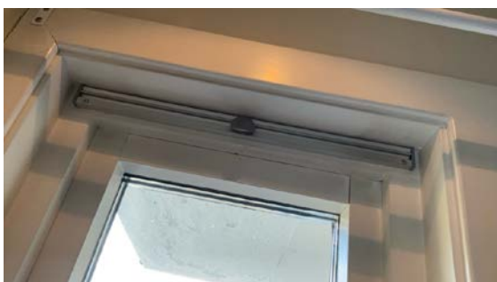
Ventiler i vindu.
