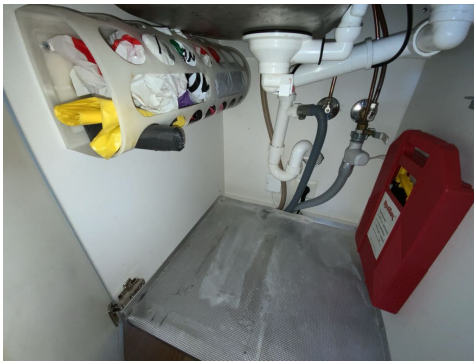
Besiktigelse av rørapplegg.
