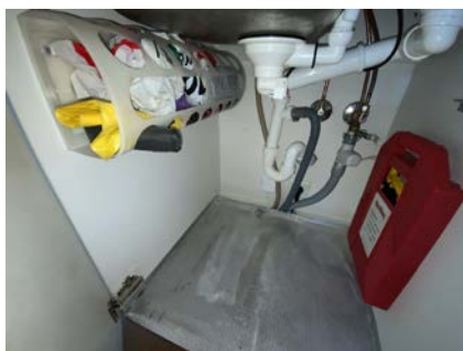
Besiktigelse av røropplegg.
