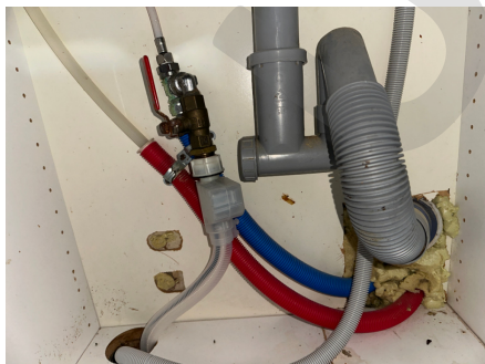
Rørproplegg i kjøkkenbenk
