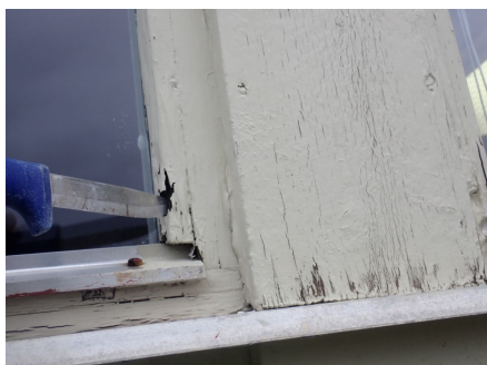
Punktert glass i vindu i trappegang 2. etasje
