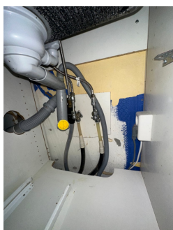
Samleskap med rørkurser og stoppekraner
