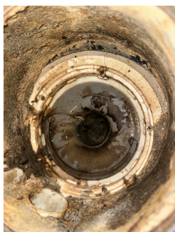
Plastsluk med klemring for membran
