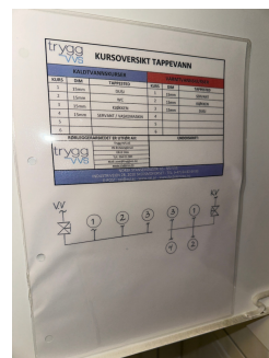
Kursoversikt for rør i samleskap
