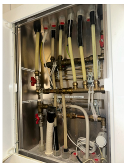
Samleskap med rørkurser og stoppekraner
