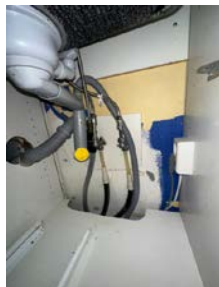
Samleskap med rørkurser og stoppekraner
