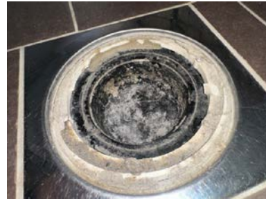
Sluk i plast, plassert i dusjnisje
