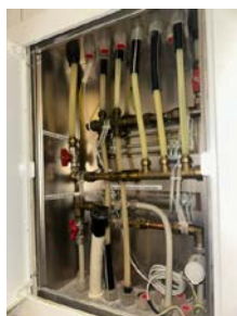
Samleskap med rørkurser og stoppekraner
