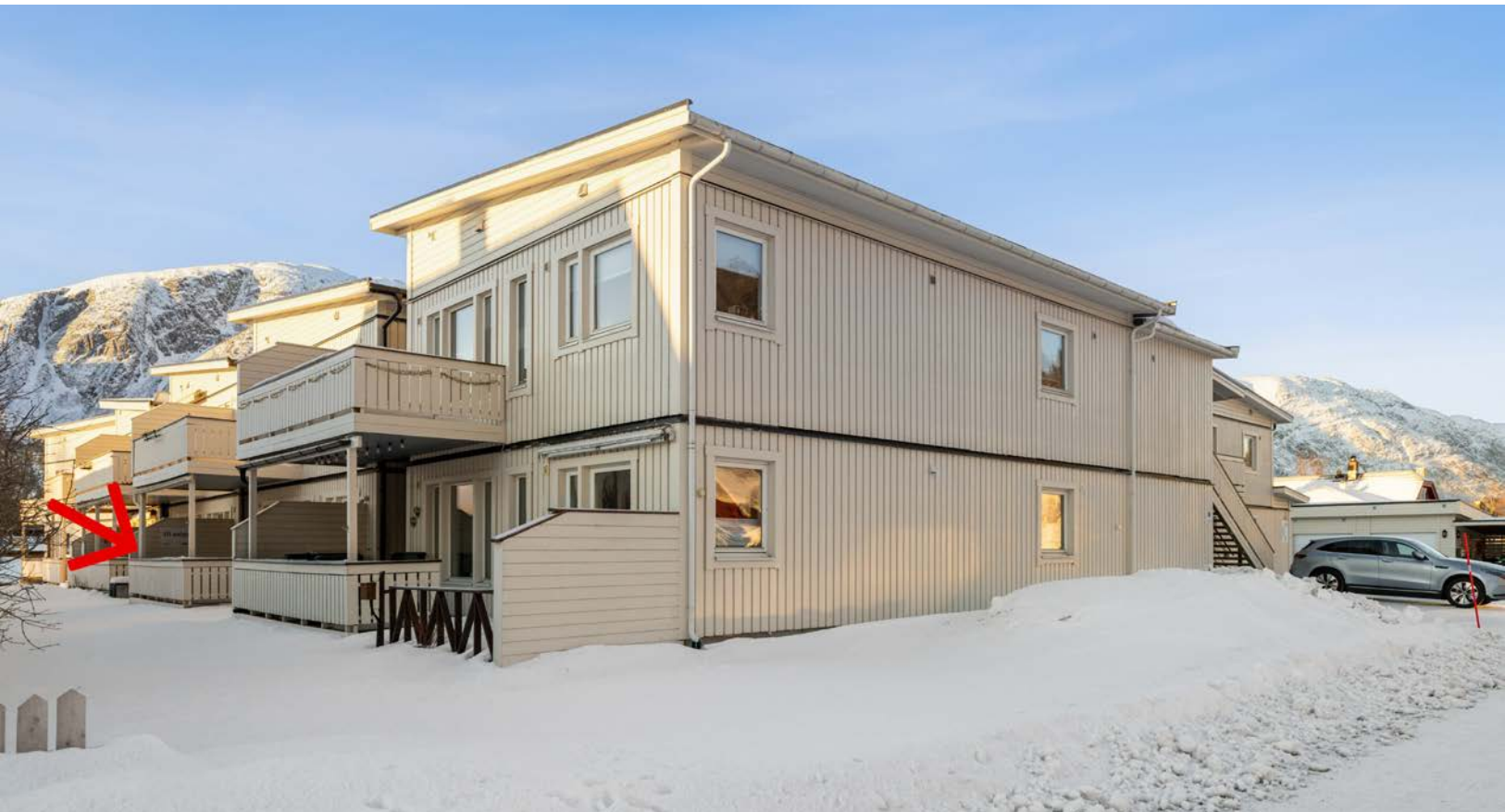
Bygget har en støpt betongsåle og yttervegger av bindingsverk med stående kledning, noe som gir en solid konstruksjon.
