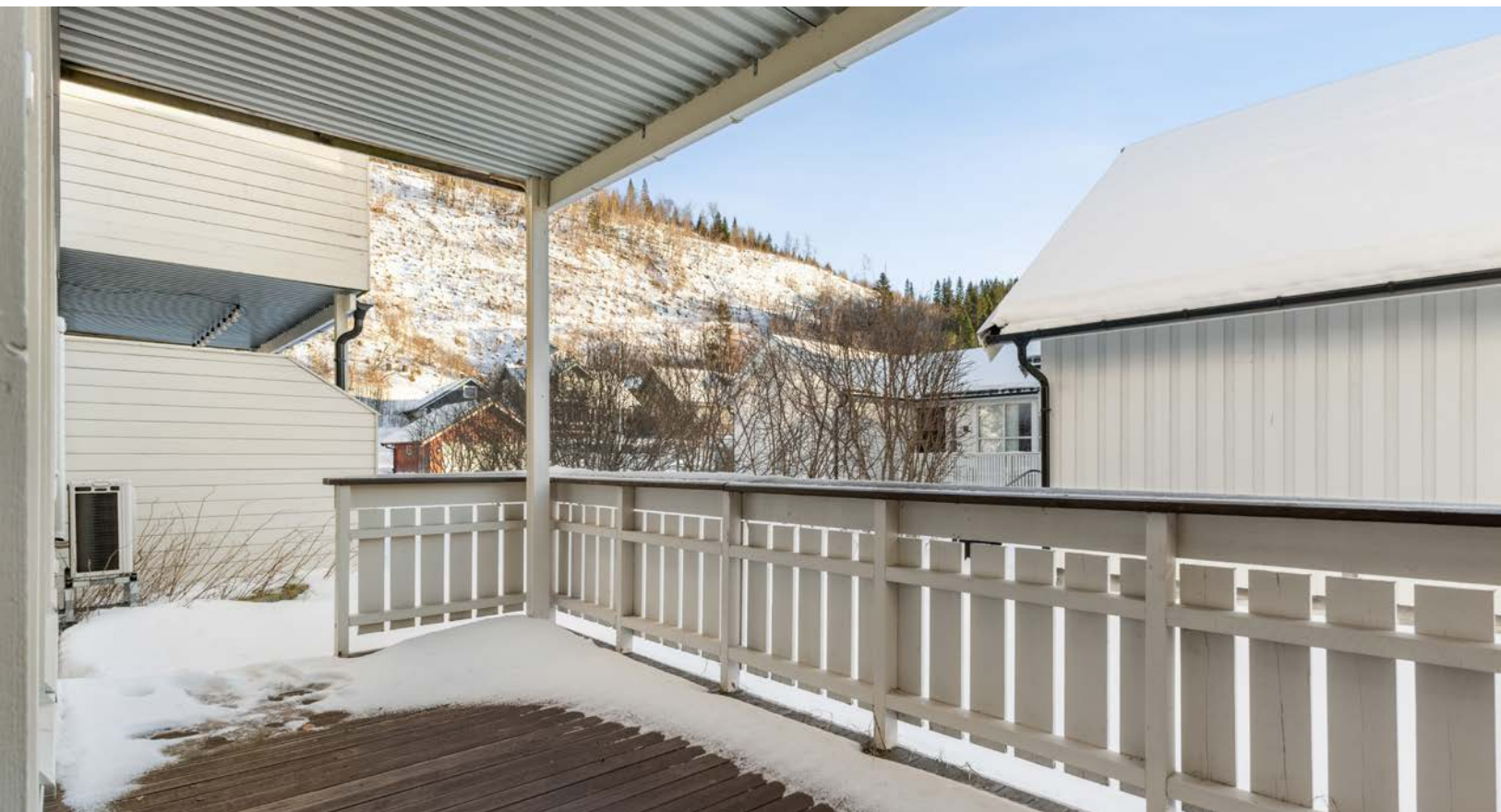
Terrassen på 14 m 2 har malt stående rekkverk og er innfestet i bygningskroppen.
