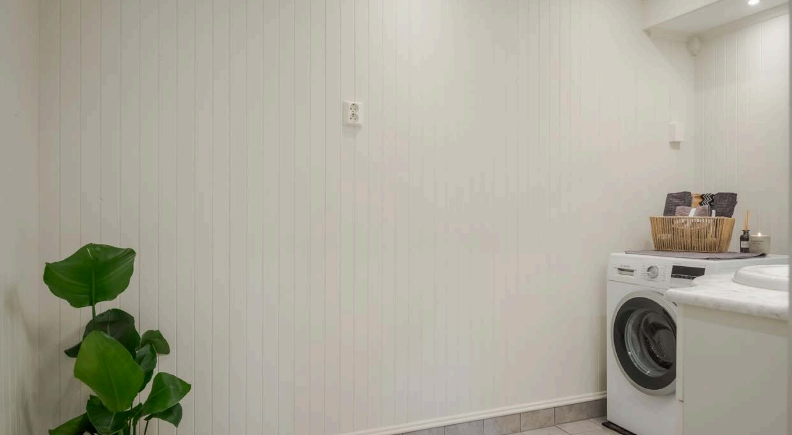
Lyst bad/vaskerom med overflater, installasjoner og komponenter fra perioden ca. 2005 til 2007. Badet har flislagt gulv med gulvvarme, panel på veggene som ble malt med våtromsmaling i 2025, downlights i himlingen og elektrisk styrt vifte.
