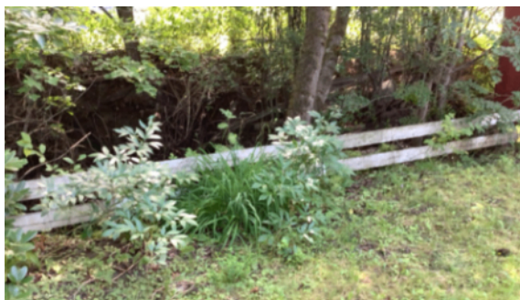
Lavt tregjerde mot skråning.
