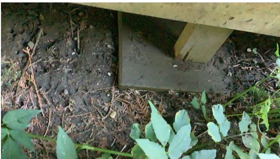
Fundamentert på betongheller og direkte på terreng.
