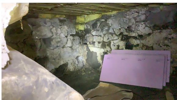
Krypkjeller sett fra inngang.
