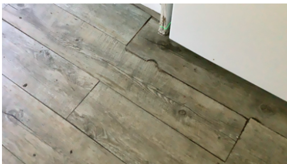
Laminat på kjøkken er ødelagt.
