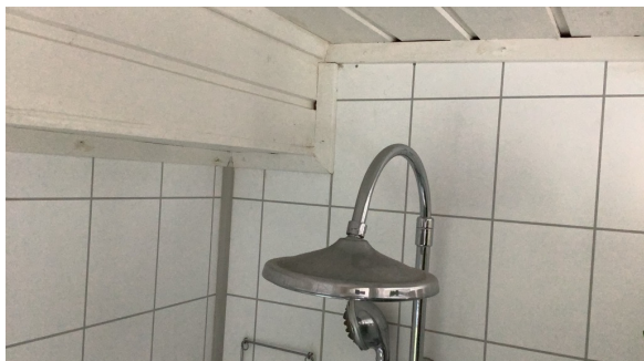
Lav takhøyde over dusj.
