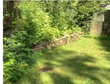
Terrengmur i jernbanesviller.
