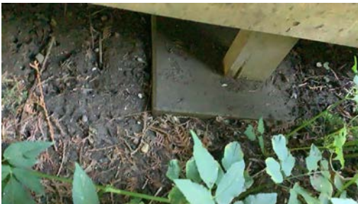
Fundamentert på betongheller og direkte på terreng.
