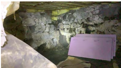
Krypkjeller sett fra inngang.
