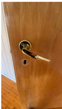
Haver henger litt (slitasje, manglende nøkkelsilt)
