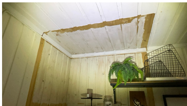
Merker etter tidl. innredning
