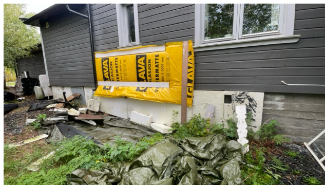
Frostsikring pga. rørføring
