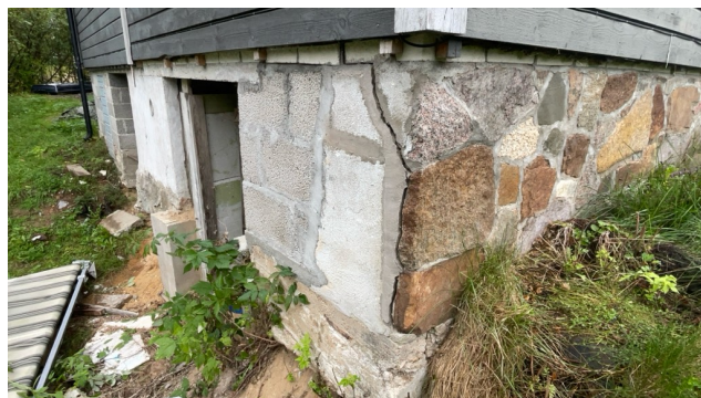
Frostsikring pga. rørføring
