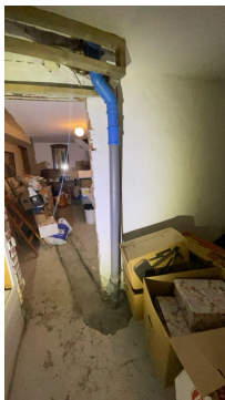
Nyere rør som går over i eldre ved kjellerhimling
