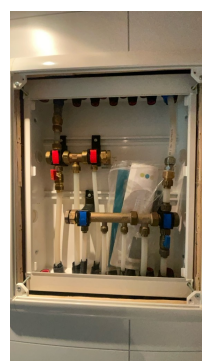
Vannskap m/nyere rør-i-rør bad
