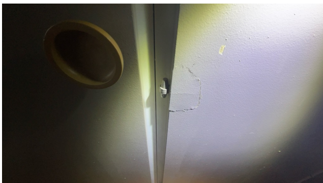
Sprekk/limt hengselinnfesting
