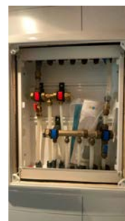
Vannskap m/nyere rør-i-rør bad
