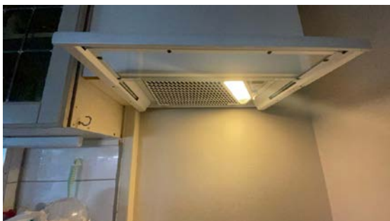
KJELLER > KJELLERROM M/KJØKKEN
