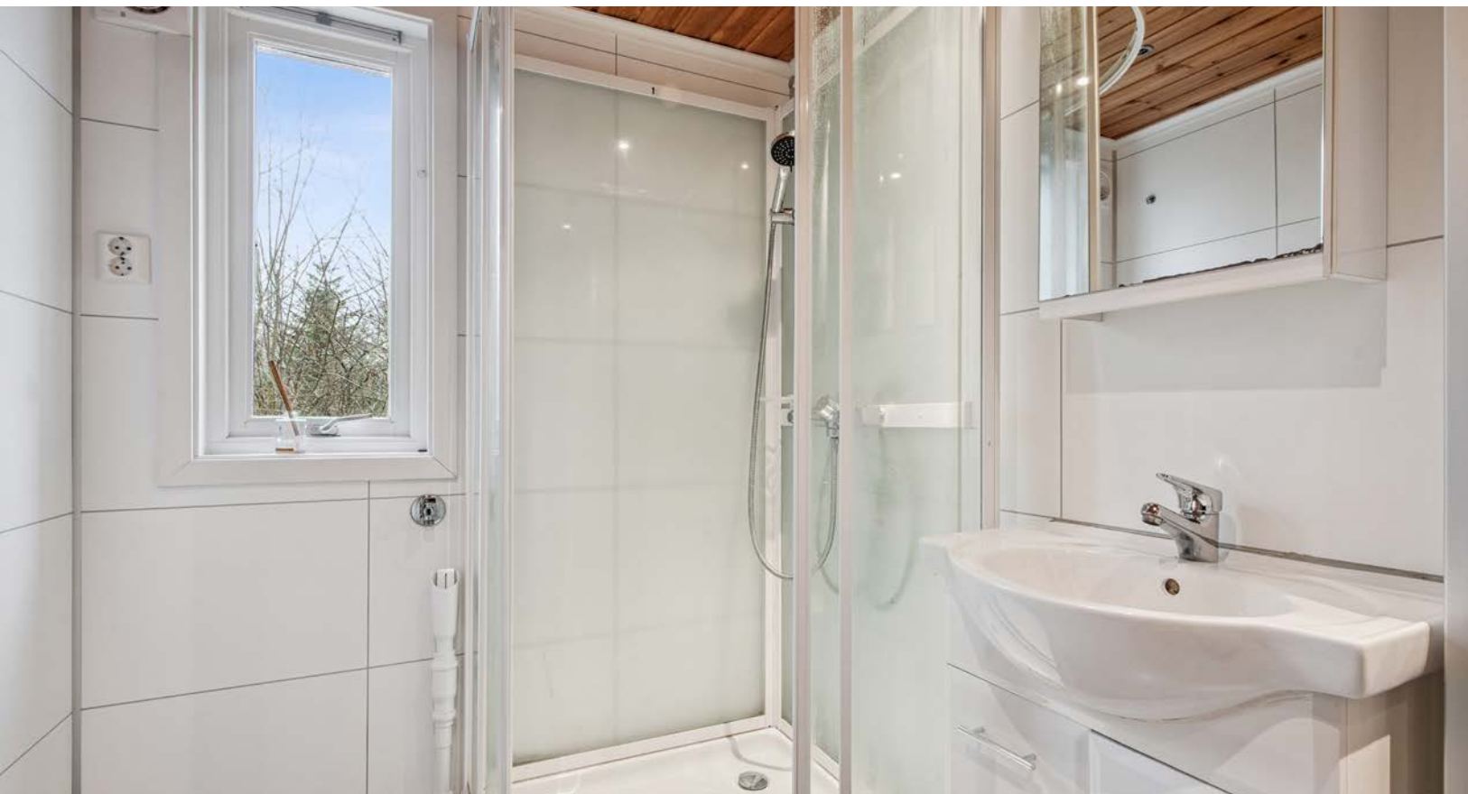
Pent bad med vinylbelegg på gulv og baderomsplater på vegger. Det er varme i gulv.
