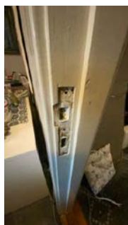
Haver henger litt (slitasje, manglende nøkkelskilt)
