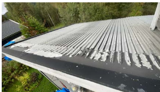
Lakkerte metallplater tilbygg
