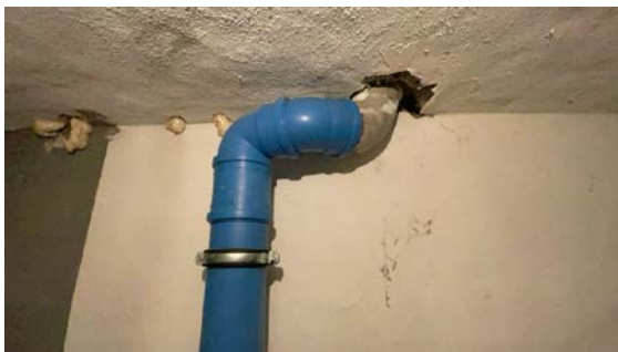
Nyere rør som går over i eldre ved kjellerhimling
