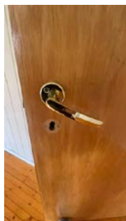
Haver henger litt (slitasje, manglende nøkkelskilt)
