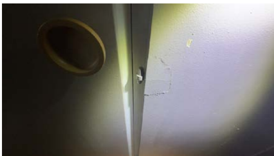
Sprekk/limt hengselinnfesting
