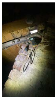
Utett rundt pipe- ikke målt unormal fukt
