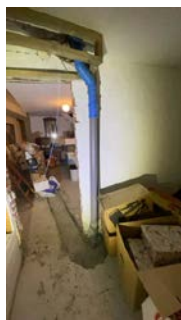
Nyere rør som går over i eldre ved kjellerhimling
