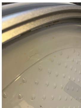
Mindre sprekk i bunn av dusjkabinett.
