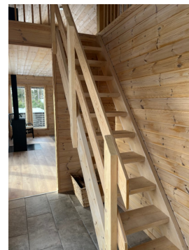
Trapp til loftetasje er ikke iht. krav om sikkerhet.
