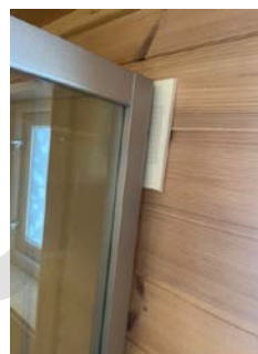
Vifte er plassert bak kabinettet.
