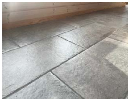
Gulvfliser i gang.
