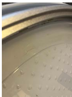
Mindre sprekk i bunn av dusjkabinett.
