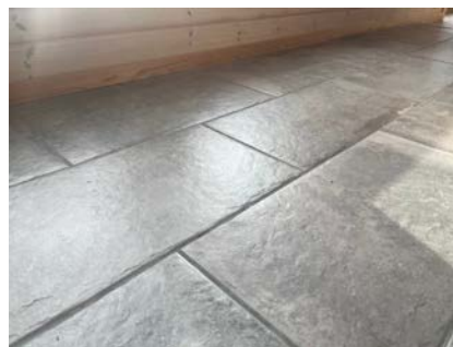
Gulvfliser i gang.
