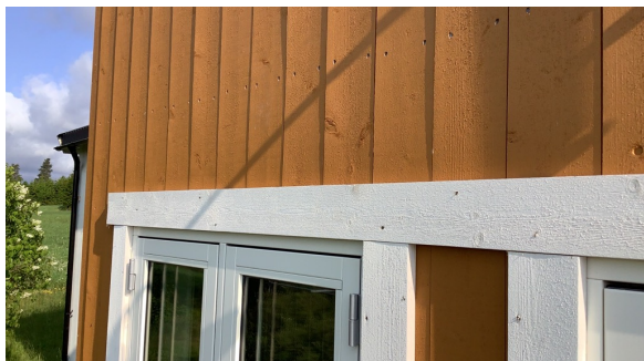
Omramming er montert utenpå kledning.
