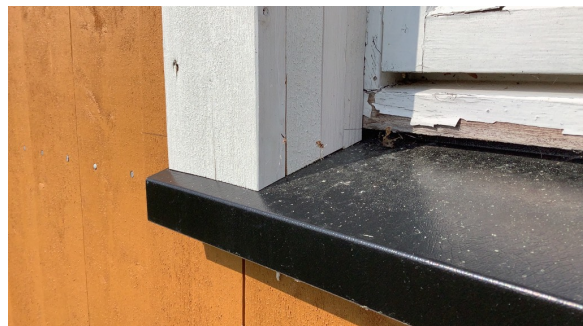
Omramming er ført helt ned til vannbrett.
