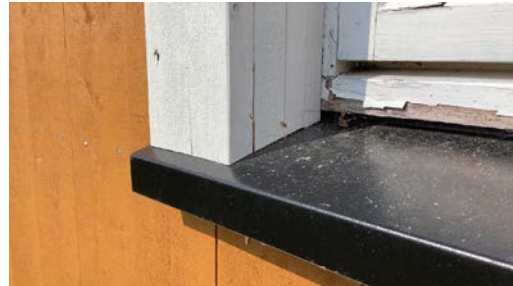
Omramming er ført helt ned til vannbrett.
