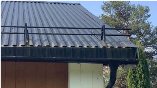
Tekkingen er avsluttet på forkantbeslag.
