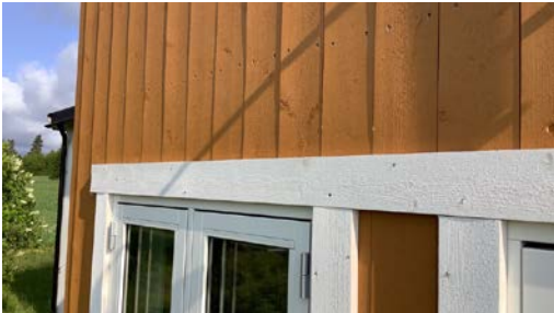
Omramming er montert utenpå kledning.
