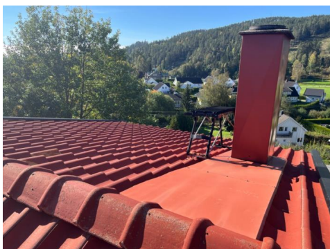
Feieplattform og heldekkende beslag på pipe.
