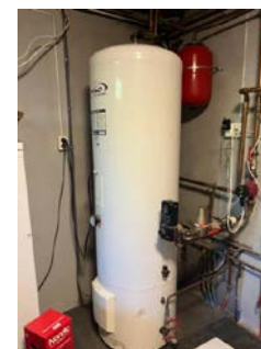
Varmtvannsbereider hoveddel.
