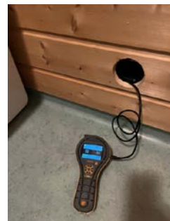
Fuktmåling på yttervegg vaskerom, uten avvik.
