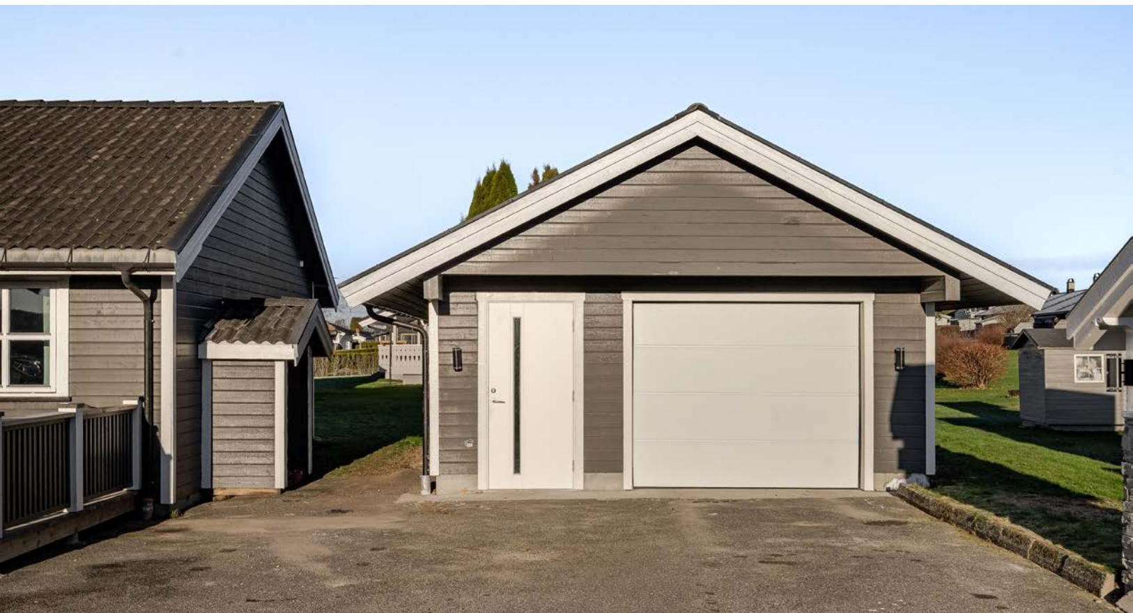
Garasjen ble bygget i 2001 og har isolert konstruksjon med støpt plate og ringmur av lettklinker, og vegger av bindingsverk.
