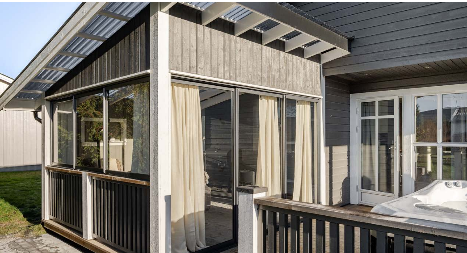
Innglasset veranda som har teppefliser og innlagt strøm, noe som gir komfort og funksjonalitet.
