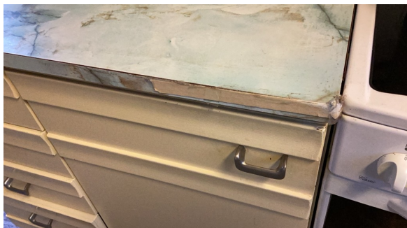
Eksempel på slitasje.
