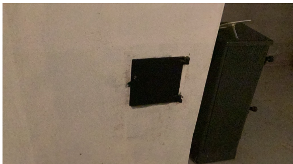
Sotluke i kjeller.
