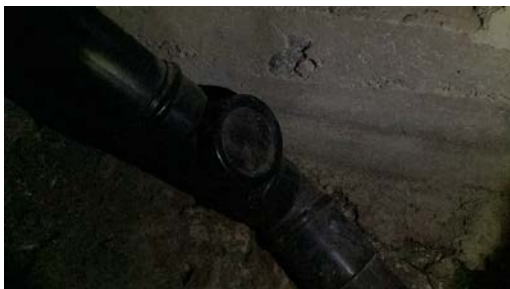
Stakepunkt i uinnredet del.
