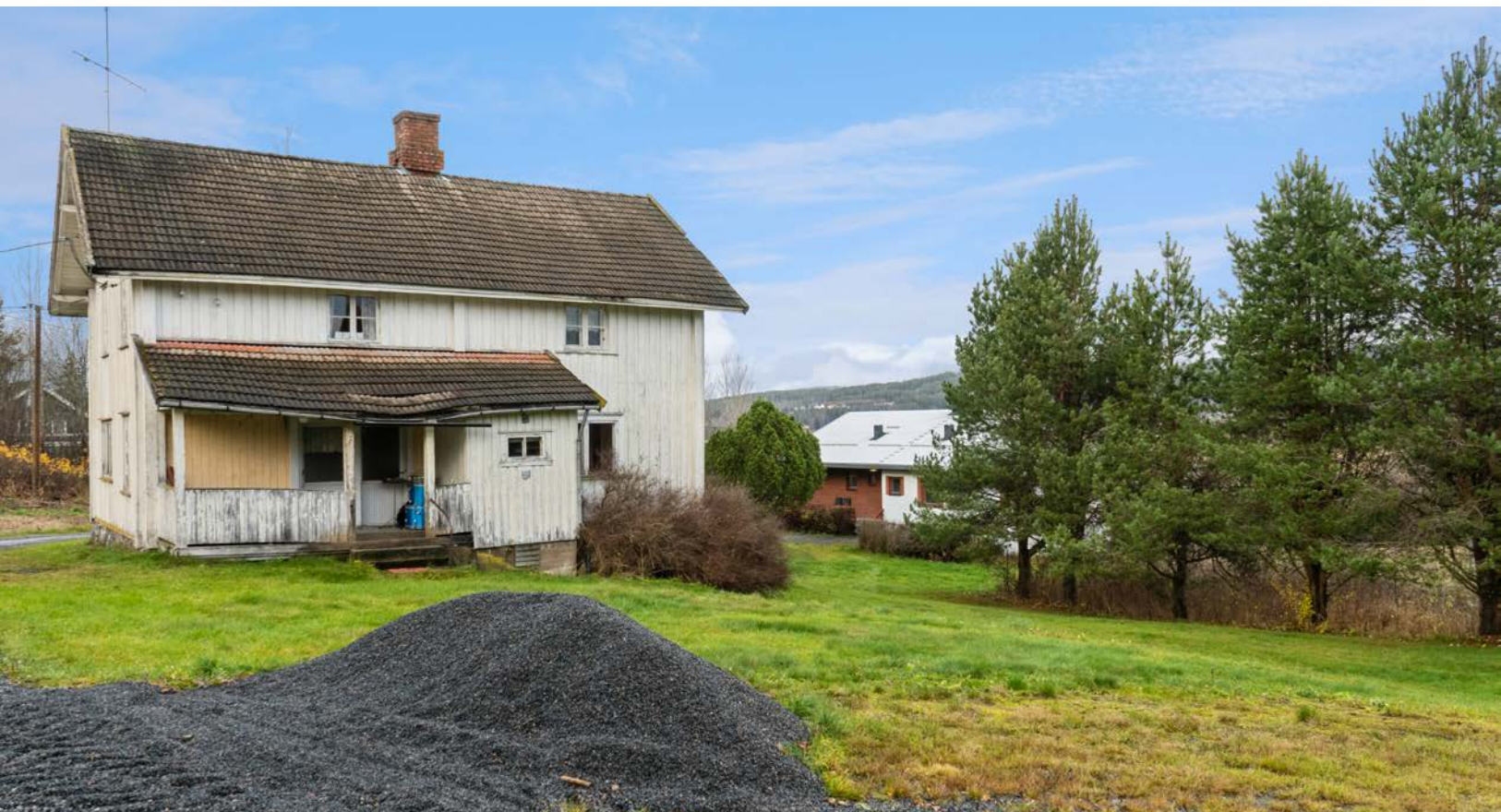
Gammelt tømmerbygg som ikke har vært bebodd etter ca 1990, og som i nåværende tilstand kun er egnet til lagerbygg.
