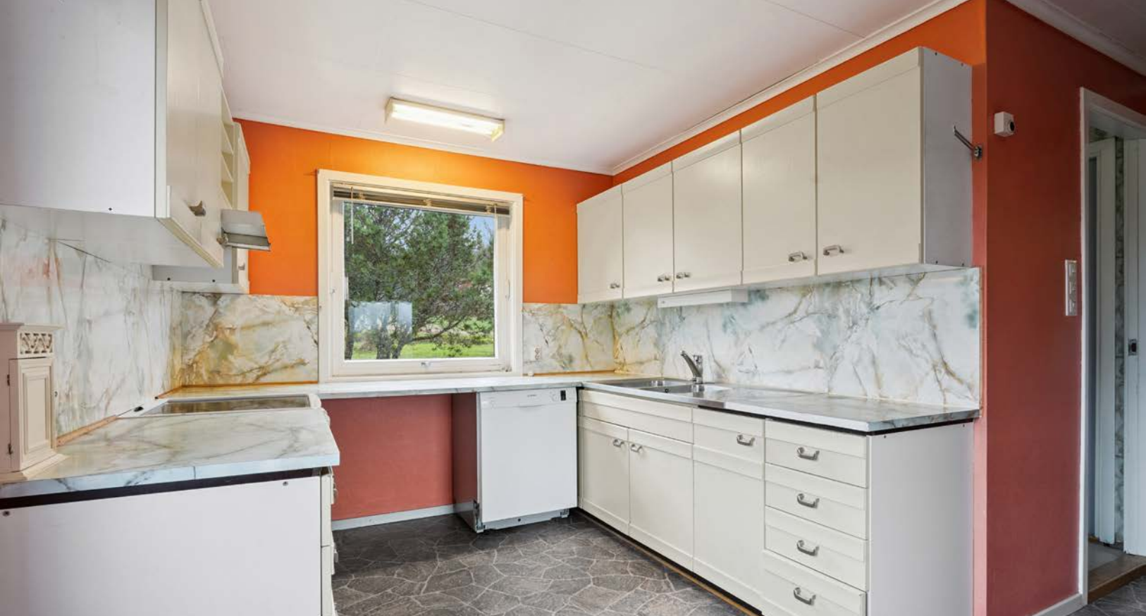
Kjøkkeninnredningen har slette fronter med pyntelister, laminerte benkeplater, vask i rustfritt stål og opplegg for oppvaskmaskin.
