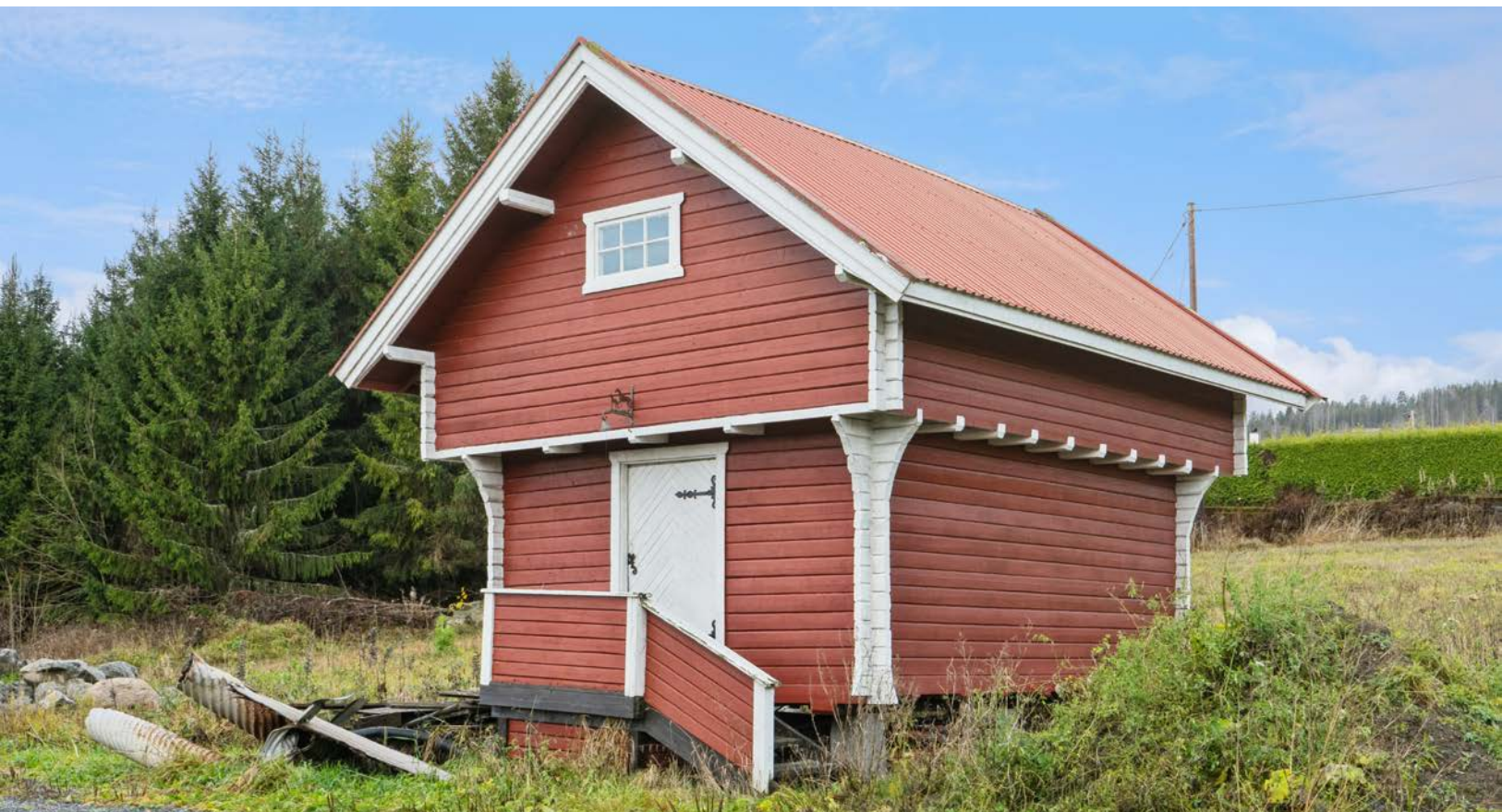
Lafteplank stabbur i 1 1/2 etasje, hvor 2. etasje er utlagt med større gulv enn grunnplan.
