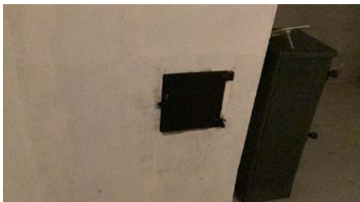
Sotluke i kjeller.
