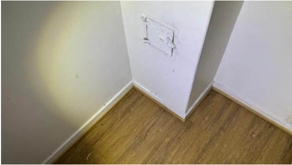
Kontroll av sotluke.
