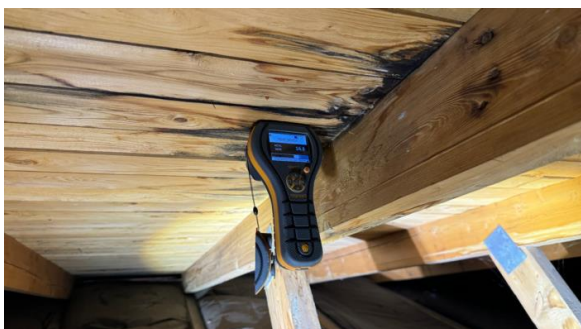
Det ble fuktmålt i taktro ved befaring, ingen unormale fuktverdier ble registrert.
