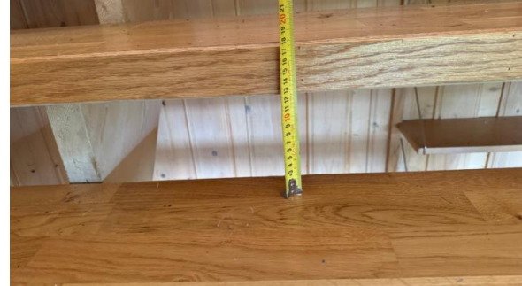
Kontroll av åpninger i opptrinn.
