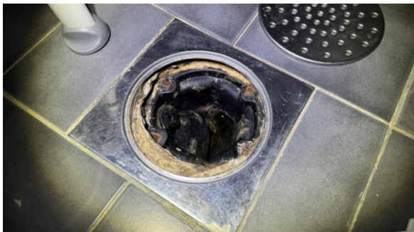
Kontroll av sluk.
