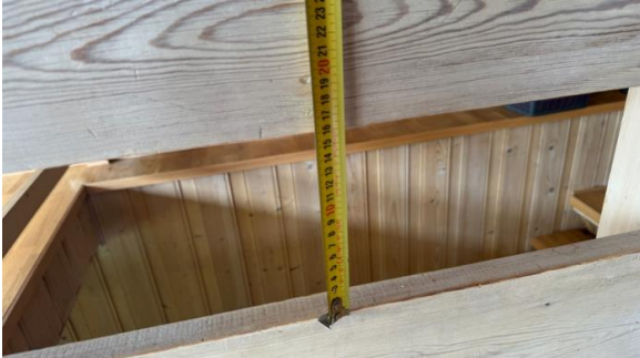
Kontroll av åpninger i rekkverk.
