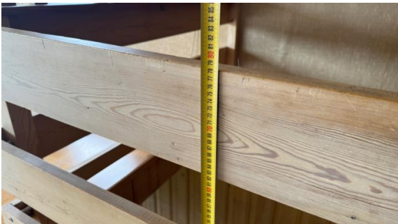
Kontroll av rekkverkshøyde.
