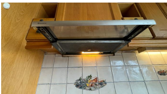
Kontroll av avtrekk.
