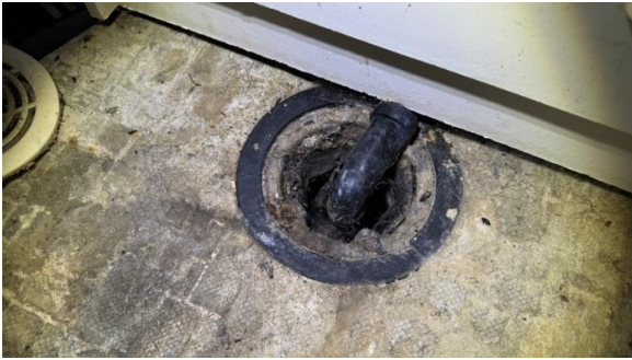
Kontroll av sluk.
