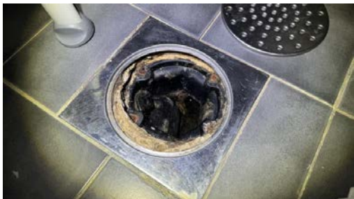
Kontroll av sluk.
