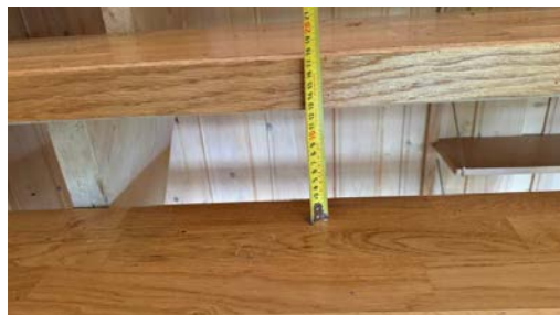
Kontroll av åpninger i opptrinn.
