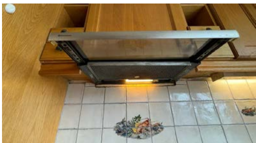
Kontroll av avtrekk.
