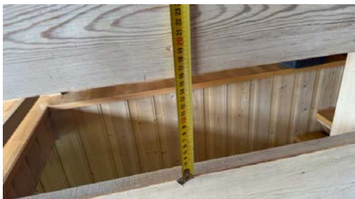
Kontroll av åpninger i rekkverk.
