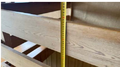
Kontroll av rekkverkshøyde.
