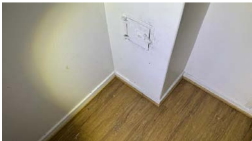
Kontroll av sotluke.
