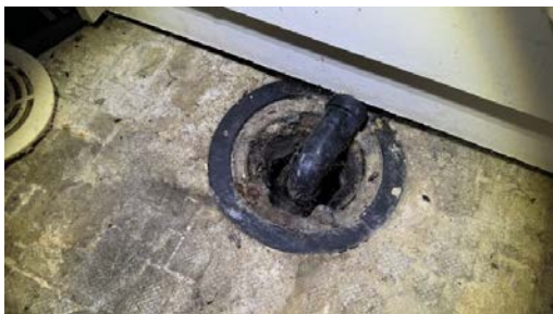
Kontroll av sluk.
