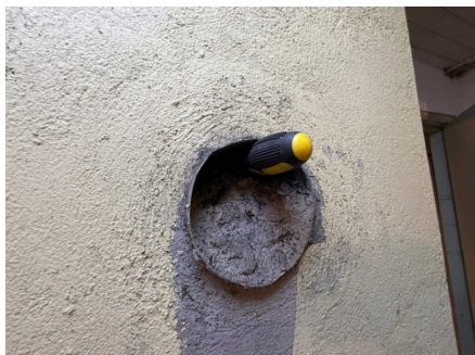
Brennbart materiale støter i mot pipen.
