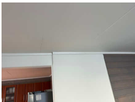
Brennbart materiale støter i mot pipen.
