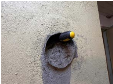
Brennbart materiale støter i mot pipen.
