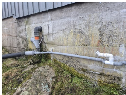
Oversiktsbilde av den eldste delen av støttemurene.
