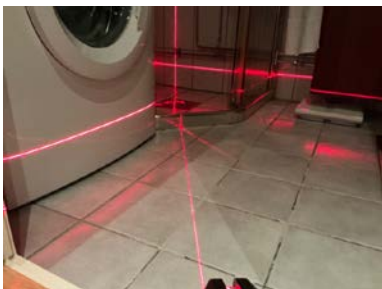
Fall på baderomsgulv er kontrollert med krysslaser.
