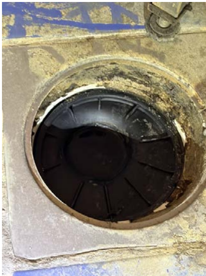
Sluket er et plastsluk og ingen tegn på skader blir registrert ved/ rundt sluket.
