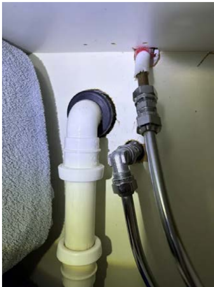
Det er ikke synlig tettesjikt rundt rørføring i vegg til servant.
