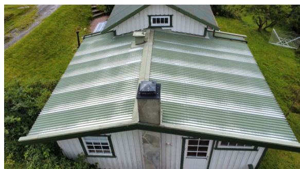
Tak på tilbygg
