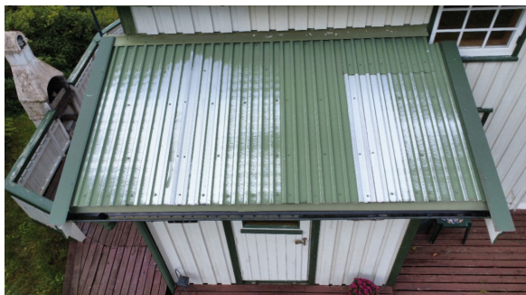
Tak over inngang
