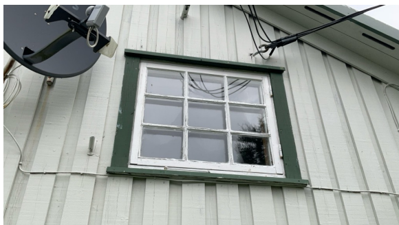
Vindu på gavelvegg
