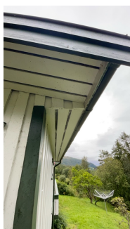
Synlig ventilering i raffekasse og på takutstikk
