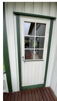
Balkongdør med utgang fra stue
