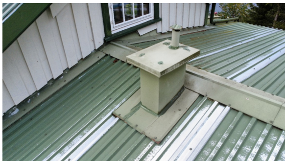
Luftehatt på tilbygg
