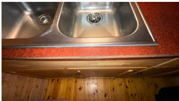
List på benkeplate ved vask er løsnet
