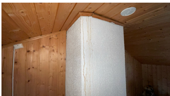
Noe rennemerker på pipeløp
