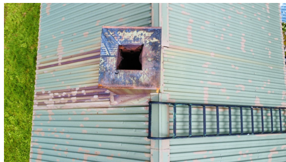
Pipehatt og takstige
