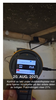
Kontroll av lekt under stubbeloftsplater mot øvre hjørne i krypkjeller på bolig. Fuktmålingen viser 21%
