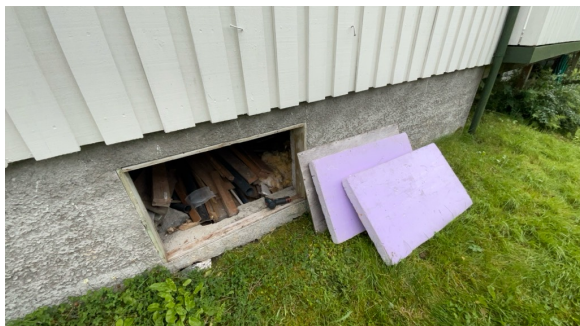
Skrudd treluke i grunnmur på forsiden av boligen med isolasjon innenfor luke
