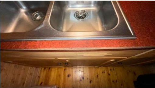
List på benkeplate ved vask er løsnet
