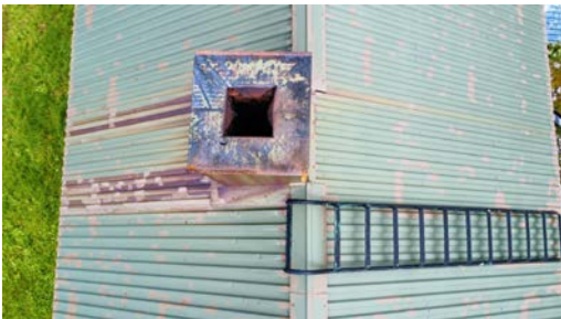
Pipehatt og takstige
