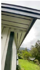
Synlig ventilering i raftekasse og på takutstikk
