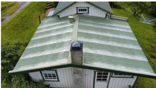
Tak på tilbygg
