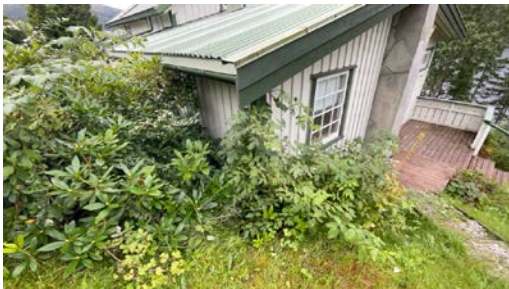
Oversikt. Etter befaringen har selger fjernet deler av plantene for å kontrollere veggen.
