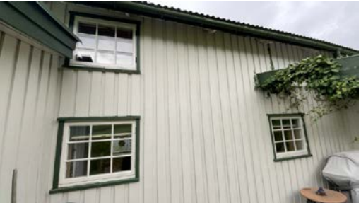
Vindu på overside av boligen.
