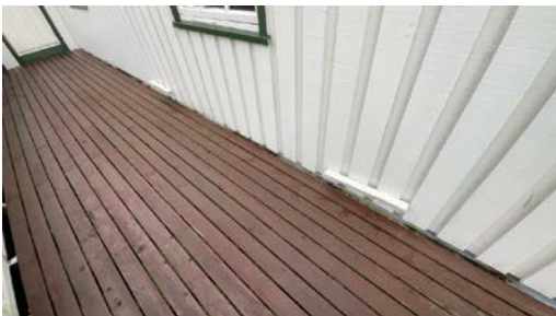
Det er montert stålbeslag/vinkler flere steder rundt boligen som sikring av tømmer knuter ifb. innvendig åpning av skillevegger
