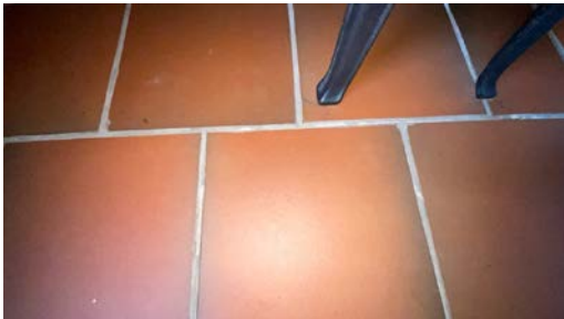
Ris/bom i flis under vedovn
