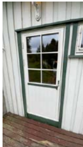
Balkongdør med utgang fra stue mot uthus og anneks
