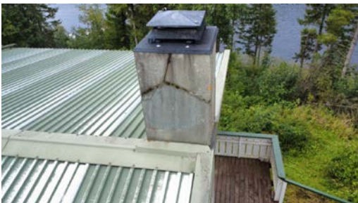
Pipe på tilbygg med skiferkledd pipeløp over tak. Montert toppbeslag med hatt
