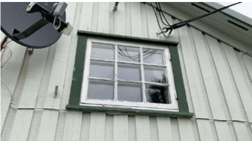
Vindu på gavelvegg
