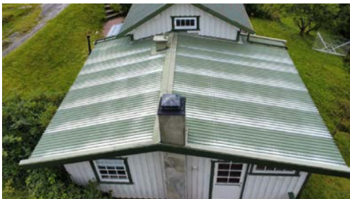
Tak på tilbygg
