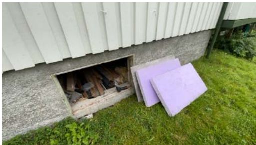
Skrudd treluke i grunnmur på forsiden av boligen med isolasjon innenfor luke
