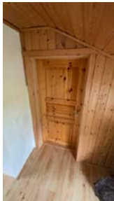
Lakkert dør til soverom sett fra allrom
