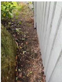
Bilde tilsendt av selger etter fjerning av planter som viser at veggen ikke har noe skader
