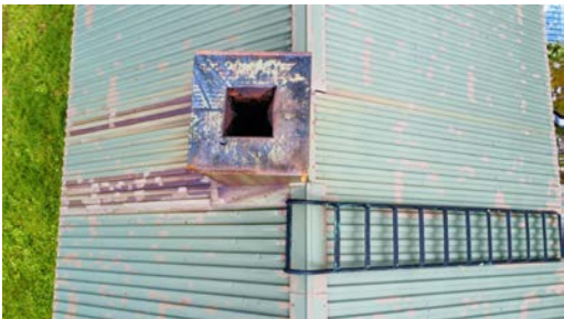
Pipehatt og takstige
