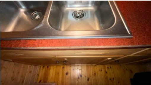
List på benkeplate ved vask er løsnet
