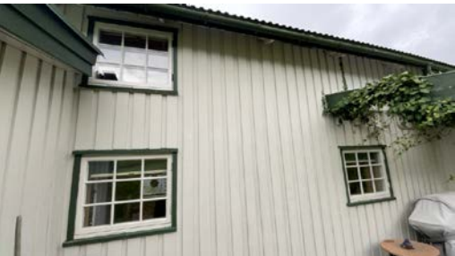
Vindu på overside av boligen.
