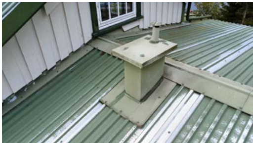
Luft hatt på tilbygg
