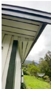
Synlig ventilering i raftekasse og på takutstikk
