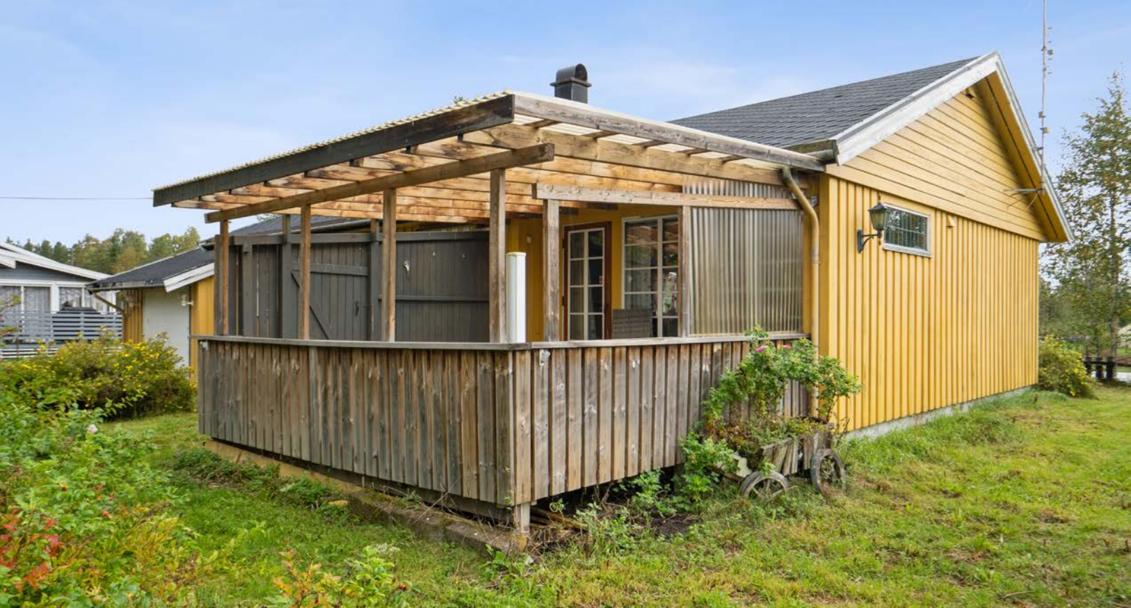
Takoverbygget terrasse v/stue bygget i 2019.
