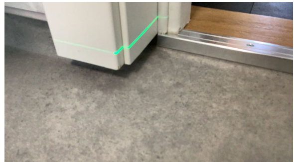
Det er etablert oppkant av membran ved dør.
